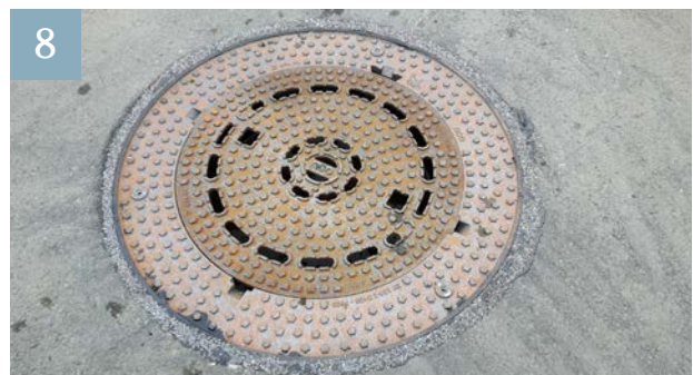
Die Abdeckung kann sofort für den Verkehr freigegeben werden
