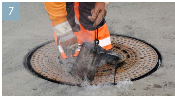
Die Anschlussfuge dauerelastisch vergießen
