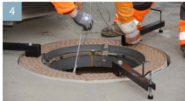
Beguplan Abdeckung einsetzen und auf Höhe ausrichten
