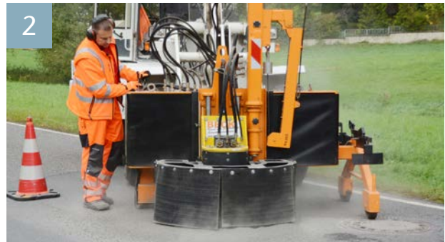
Schadhafte Abdeckung ausbohren
