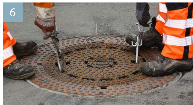
Nach dem Entfernen aller Einbauhilfen den Deckel einlegen
