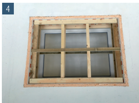
4 Aussteifungsrahmen einfügen und Leibungselement rundum einschäumen.
