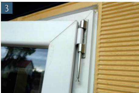
3 Axerarm dem Axerlager zuführen und den Axerstift bis zum Anschlag nach oben drücken
