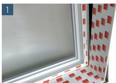
1 Nach erfolgter Therm Block-Montage das Leibungselement in die Nut der Fensterzarge einschieben
