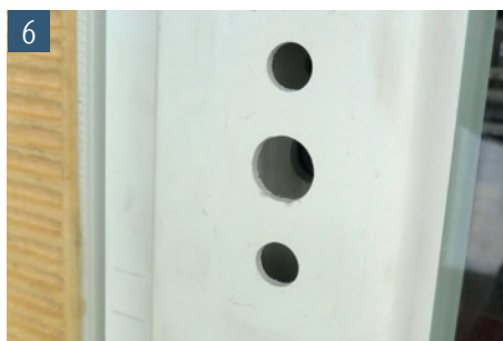
6 Griffolive entfernen, um Beschädigungen in der Restbauphase zu verhindern
