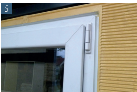
5 Abdeckkappe für Axerlager aufstecken
