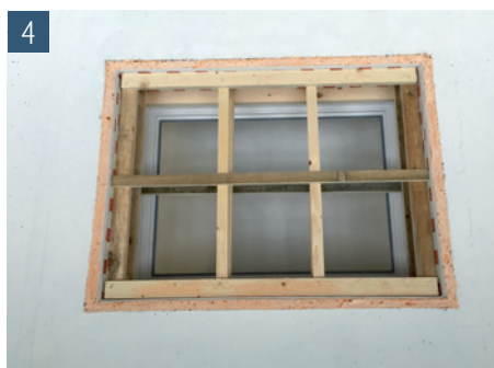
4 Aussteifungsrahmen einfügen und Leibungselement rundum einschäumen
