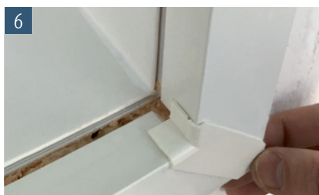
6 Abdeckwinkel zusammenstecken und in Dichtungsnut einklicken
