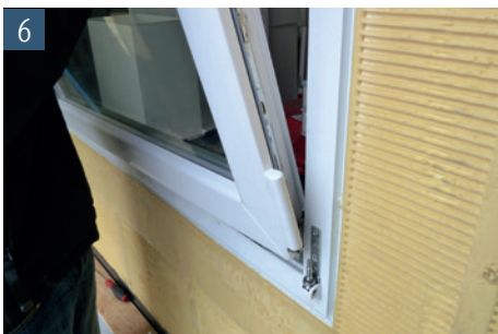
6 Flügel anschließend vom unteren Ecklager heben
